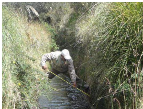
Canal del río Mal Paso
